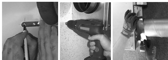
C - Wand- oder Deckeninstallation: Zwischen jeder Befestigung und der Wand oder Decke Schwingungsdämpfer installieren.
